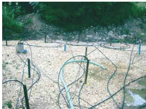
Assainissement biologique de sols contaminés par des solvants chlorés. (Photo MADEP/Infors)
