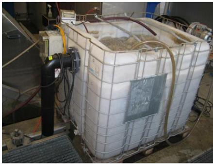
*Bioréacteur de 1m<sup>3</sup> permettant de produire en continu les bactéries pour traiter les biofiltres*
