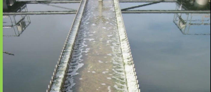
Sortie décanteur secondaire (sortie STEP)
