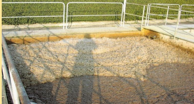
Sortie décanteur secondaire (sortie STEP)
