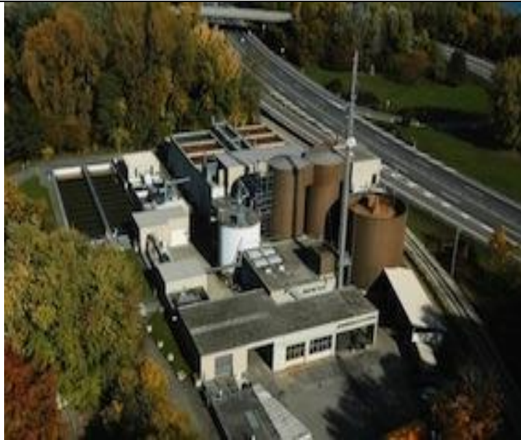
Vue aérienne de la STEP
